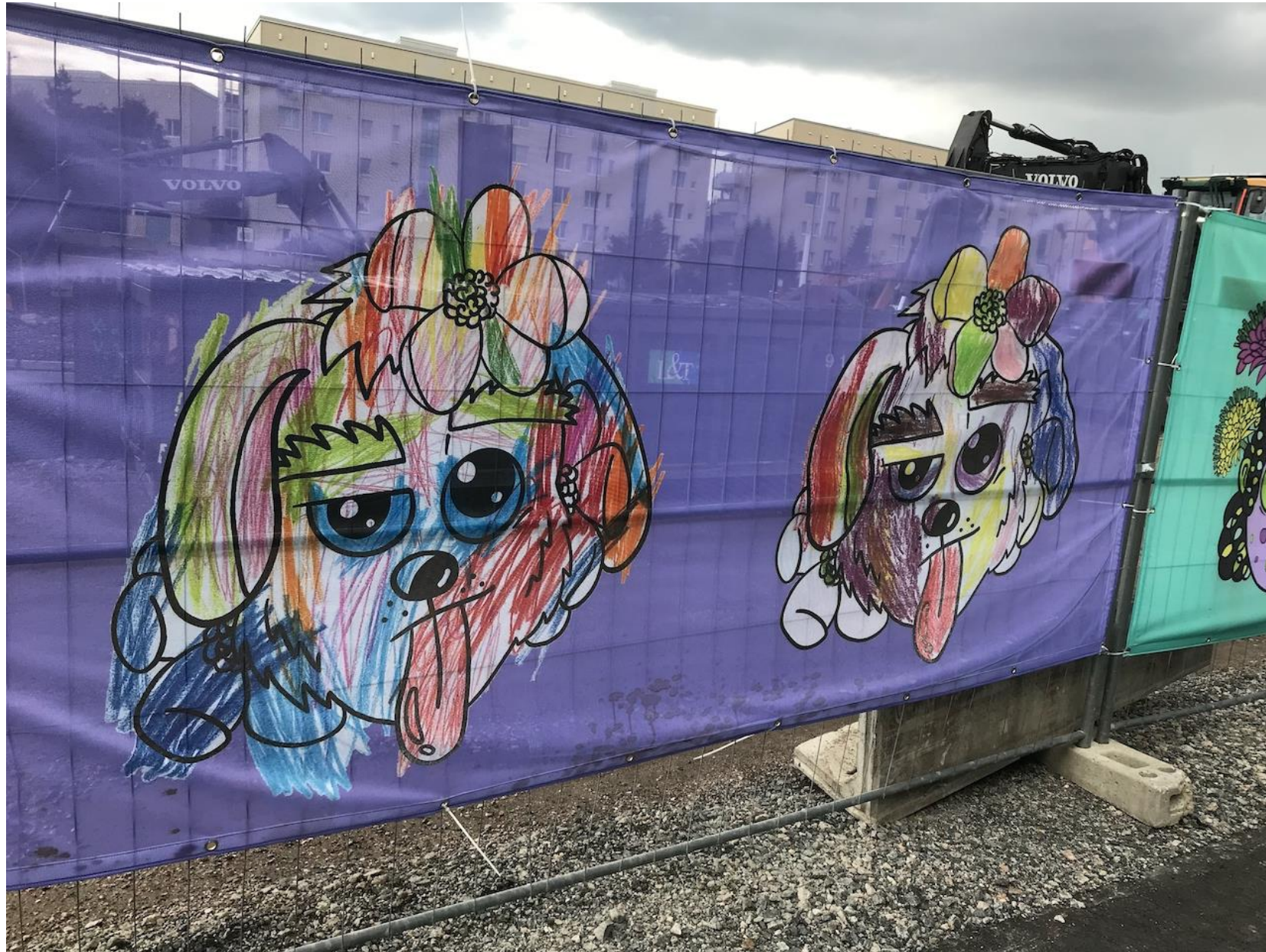
Työmaa-aita Helsingissä raitiotietöyömaan varrella syksyllä 2022. Työmaa-aitaan toteutettiin yhteisötaideteos yhdessä tubettaja Nelli Orellin ja lähialueen päiväkotilasten kanssa. Kuva: Moona Tikka
