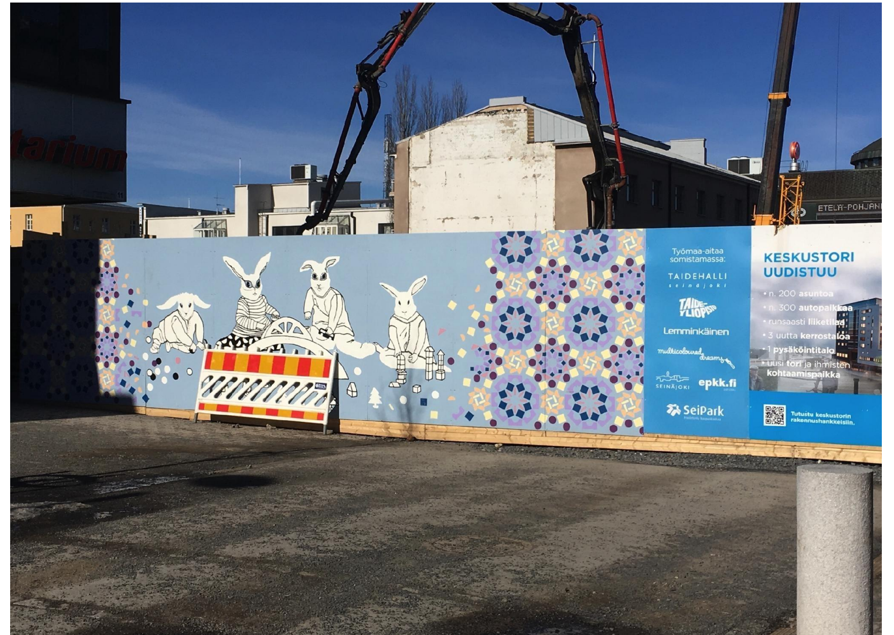
Seinäjoen Keskustorin työmaa-aitaa koristivat Multicoloured Dreams -kollektiivin taideteos. Kuva: Mika Virkkala
